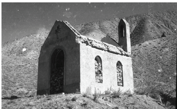
کلیسای سرخ‌آباد در دهه‌های بعد از ساخت راه‌آهن که رو به خرابی است
